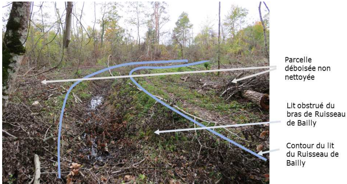
Figure 24 Branchages obstruant le lit de l'affluent nord de l'étang de Marcenay, localisation sur une parcelle en bordure de la ceinture boisée de l'étang (1/2), vue vers l'amont du ru, Source : Photointerprétation MapLab Nomadéis 2015
